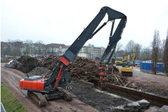
DSC 0072.jpg Motiv: Rückbau Betonwanne Westwand
