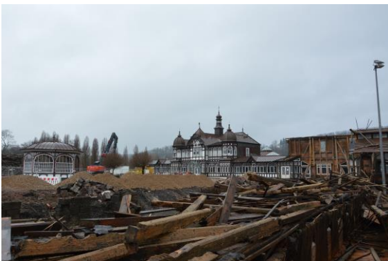
DSC 0090.jpg Motiv: niedergelegte Ostwand und Mittelbau
